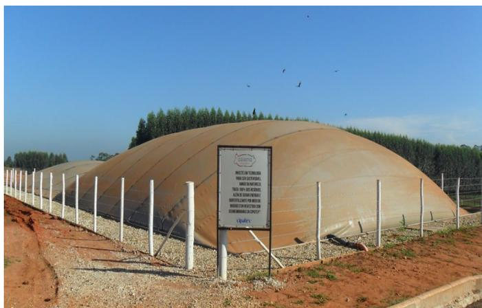
O biogás é usado como combustível para as máquinas de caldeiras. O vapor é utilizado no processo de produção do Cowpig.
