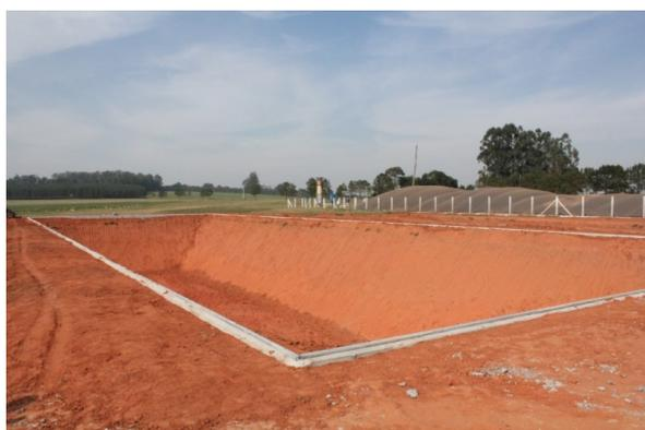
Etapa 2: Instalação do Cipageo TEXTIL 1,00mm mais um reforço de geotêxtil como revestimento.
